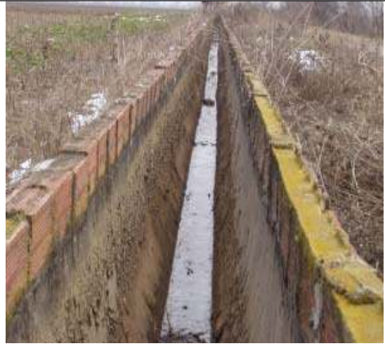
Αυλάκι νερού (τσιμενταύλακο) avlaki neru (tsimedavlako) Ditch
